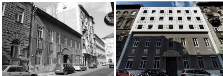
1.-2. kép Zichy utcai emeletréépítéssel megvalósuló épületrekonstrukció, saját fotó
